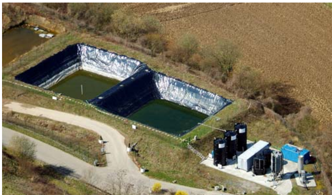
La station de traitement des lixiviats et les bassins de stockage
