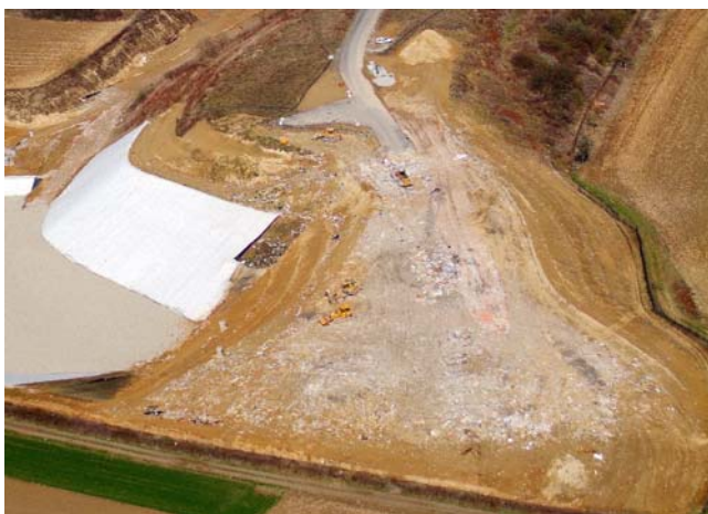
Le casier en exploitation jusqu'à Août 2006
